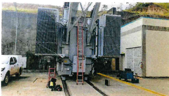
Figura 10 - Detalhe vista lateral
