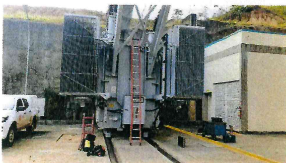
Figura 10 - Detalhe vista lateral
